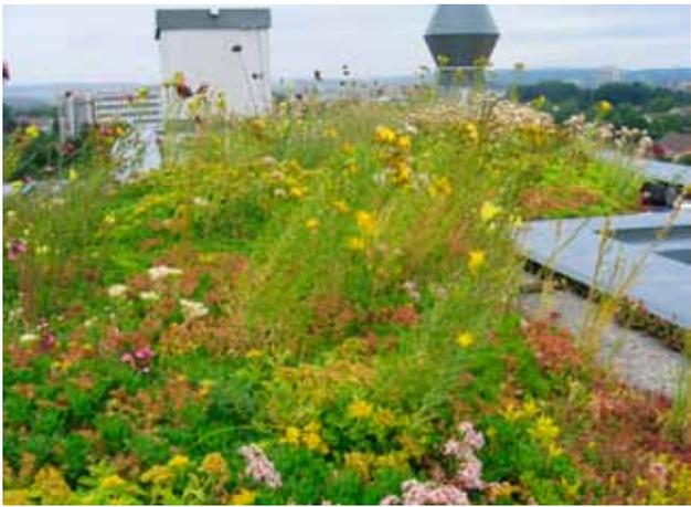
Dachbegrünungen tragen durch ihren Verdunstungseffekt nicht nur zur lokalen Temperaturreduktion bei, sondern sind gleichzeitig eine Wärmedämm- bzw. Kühlmassnahme für das Gebäude.
