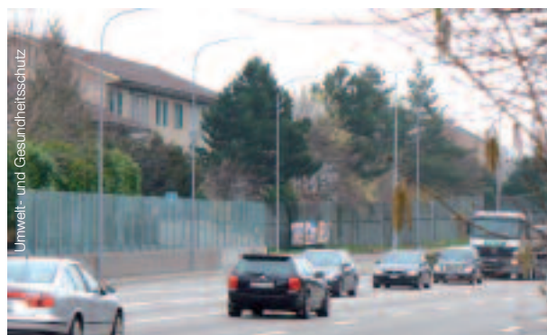
Wände sorgen für Lärmschutz auf dem Ausbreitungsweg, sind allerdings nicht überall mit dem Stadtbild verträglich.
