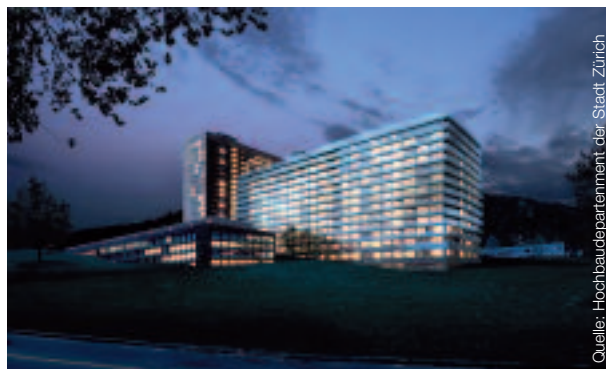
Das neue Bettenhaus Triemlispital – ein Leuchtturm auf dem Weg zur 2000-Watt-Gesellschaft
