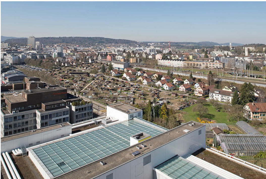
Blick von Norden auf die bestehenden Nutzungen des Areals
