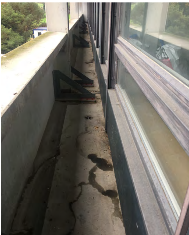
Abb 7: Balkonebene mit geschlossener Brüstung
