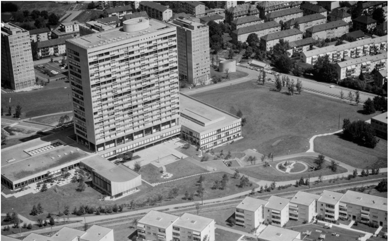
Abb. 2: Luftaufnahme von Süden, 1971
