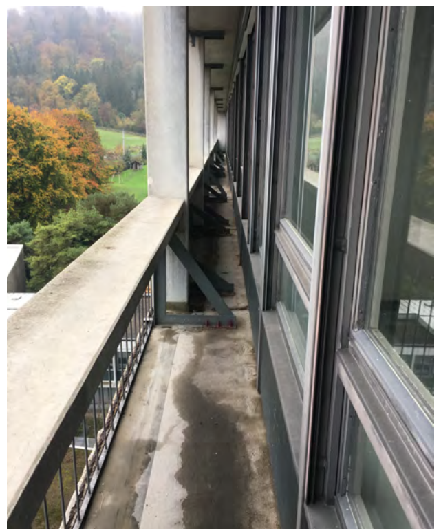
Abb 8: Balkonebene mit im Vordergrund offener Brüstung
