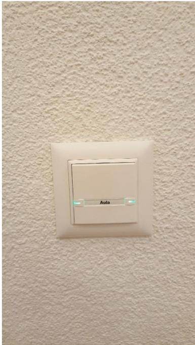
Abbildung 1: KNX-Lichtschalter mit Status-Anzeige LED grün/ rot.
