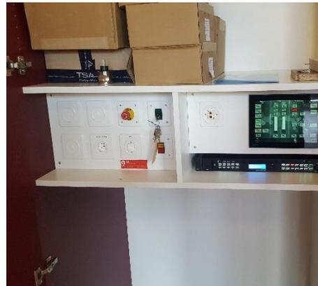
Abbildung 8: UP Touchpanel mit Einzelbuttons
