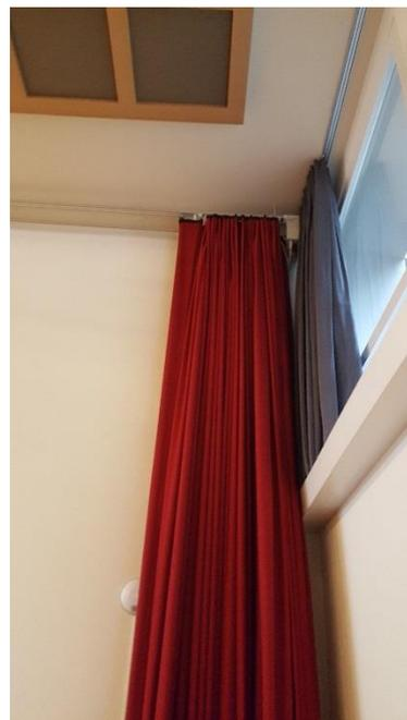
Abbildung 14: Roter elektr. Bühnenvorhang und elektrischer Verdunkelungsvorhang
