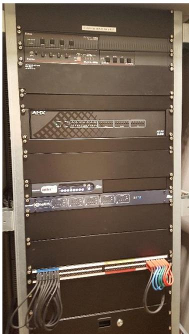
Abbildung 13: Rack Bühnentechnik mit Verstärker der Hörlosenschlaufe
