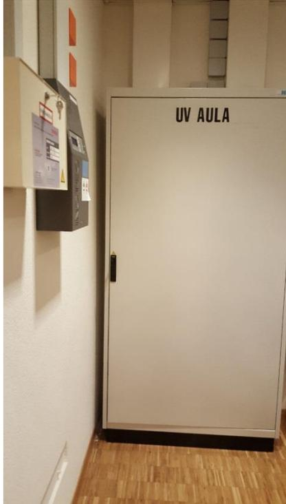
Abbildung 11: Separater Technikraum mit Ansicht auf Elektroverteilung und Notlichtzentrale 24V DC.
