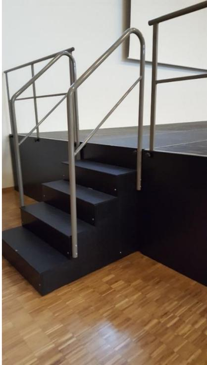
Abbildung 9: Treppenaufgang mit Geländer auf mobile Bühne gemäss SUVA
