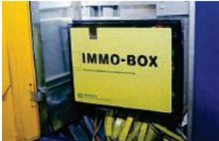
Abbildung 24: IMMO-Box zur Erfassung der Energie- und Medienverbräuche
