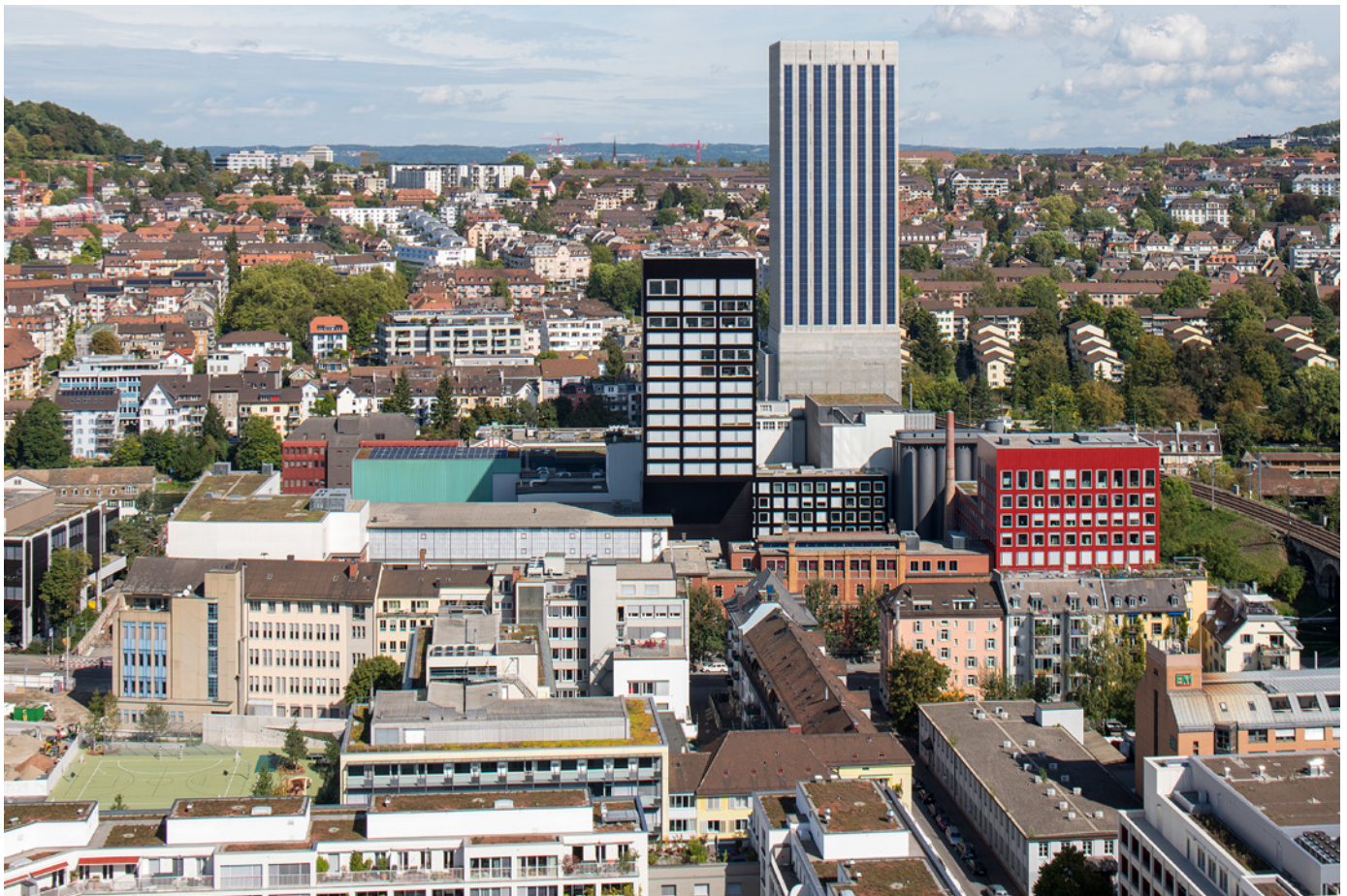
Swissmill Silo mit PV-Anlage
