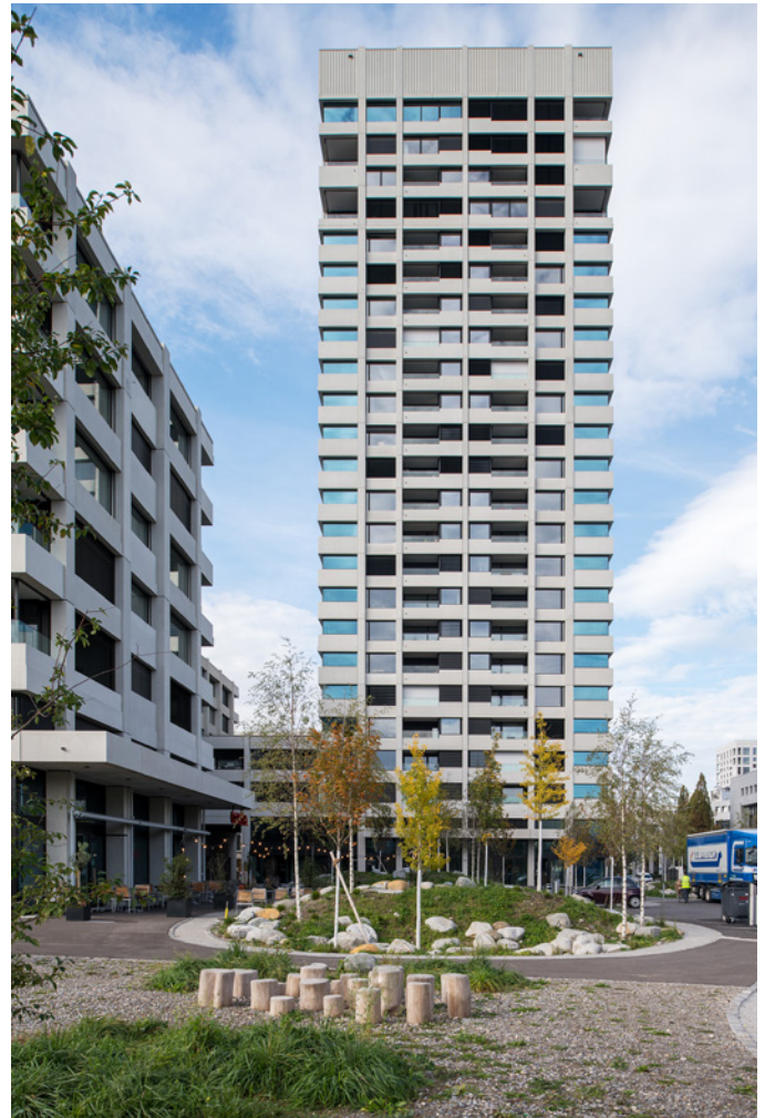
Hochhaus Ecke Basler-/Flurstrasse
