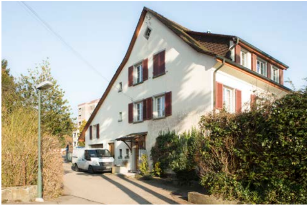
Abb. 100: Kernzone Riedhof: Riedhofstrasse 351
