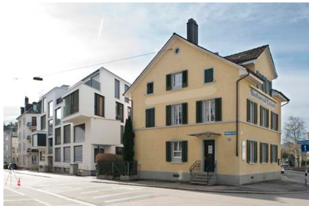
Abb. 80: Kernzone Kieselgasse, Wildbachstrasse mit Baumeisterhaus und Ersatzneubauten
