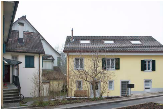
Abb. 86: Kernzone Drahtzug: Hammerstrasse
