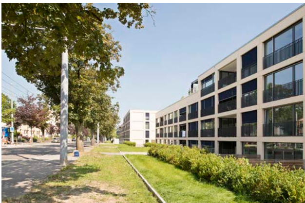
Abb. 28: Wohnungen im anrechenbaren Untergeschoss: Terrasse gegenüber Strassenraum abgesenkt
