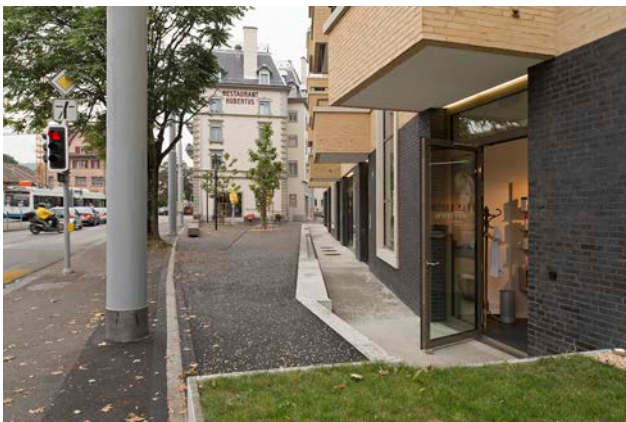
Abb. 26: Publikumsorientierte Nutzungen im anrechenbaren Untergeschoss gegenüber Strassenraum abgesenkt
