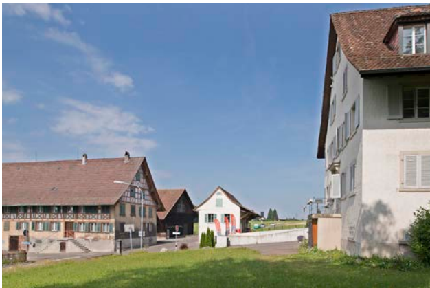
Abb. 98: Kernzone Köschenrütli: Räumliche Sichtbezüge zwischen den einzelnen Hofgebäuden
