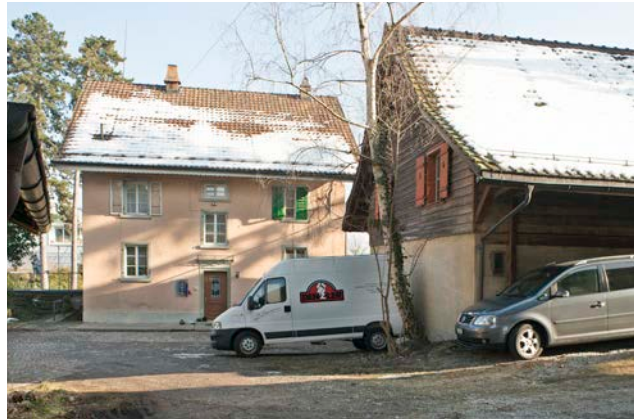
Abb. 101: Kernzone Riedhof: Riedhofstrasse 357
