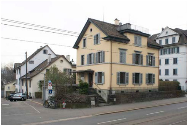
Abb. 94: Kernzone Honrain: Honrainweg von Seestrasse, gewachsene Baustrukturen
