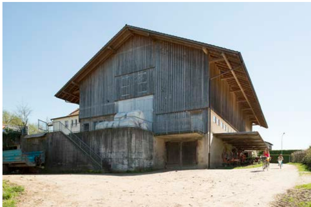
Abb. 111: Kernzone Waidhof: Stattliche raumbildende Scheune
