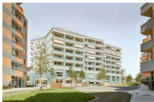
Aussenaufnahme des Gesundheitszentrums für das Alter Eichrain neben der gleichnamigen städtischen Wohnsiedlung. (Foto: Karin Gauch, Fabien Schwartz)
