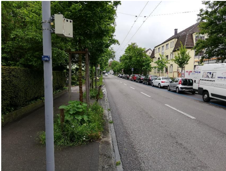
Abb. 2 Montage Seitenradargerät Gladbachstrasse
