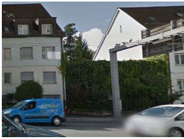
Abbildung 10: Lärmschutzwand zwischen Gebäuden (Quelle: Google)
