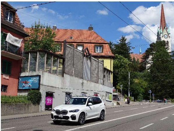
Abbildung 5: Stützmauer und Lärmschutzwand
