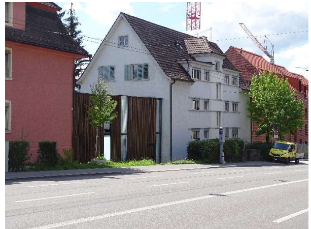
Abbildung 4: Lärmschutzwand zwischen Gebäuden
