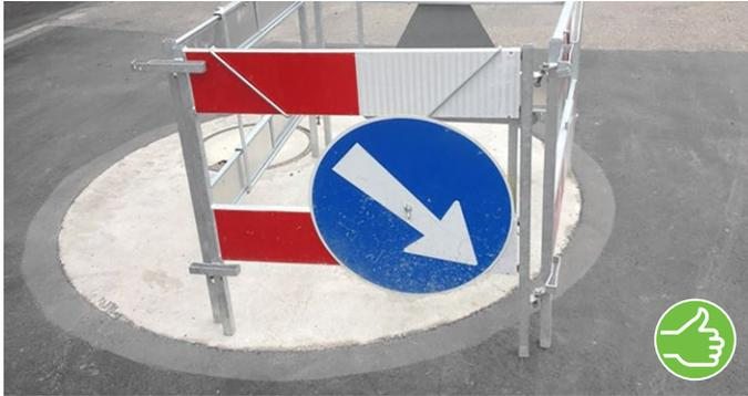
Um die Baustelle abzusichern, muss bei Baustellenabschrankungen die obere, horizontale Baulatte gemäss Norm installiert sein. Im Fussgängerbereich ist die untere Baulatte maximal 30 cm über Boden anzubringen. Es können auch drei Lattenreihen verwendet werden.
