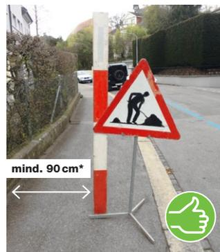
Unabhängig vom verwendeten Standfuss kann ein Baustellensignal mit einer vertikal befestigten Baulatte taktil erfassbar gemacht werden.
