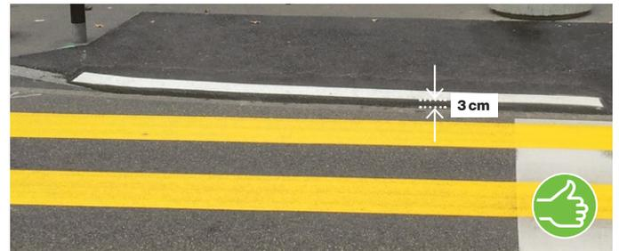
Alte Randabschlüsse sind durch Anrampungen mit max. 18 % Neigung oder Entfernung der Steine zu eliminieren.
