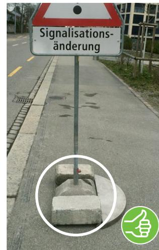
Signaltafeln sind dank einfacher Montage von Schutzelementen am Sockel taktil erfassbar. Schutzelemente sind bei der Dienstabteilung Verkehr erhältlich.
