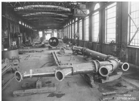
Titel: Pumpwerk Zürich, Verteilung
