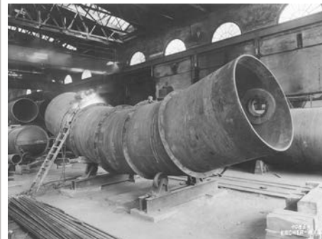
Titel: Etzelwerk, Elektrisches Schweißen von Krümmer
