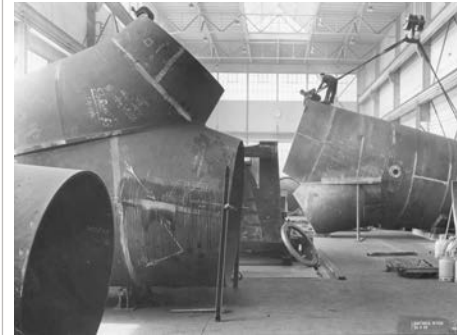
Titel: Sils, Montage von Abzweigrohren
