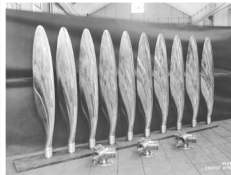
Titel: Blätter und Naben fertig bearbeitet
