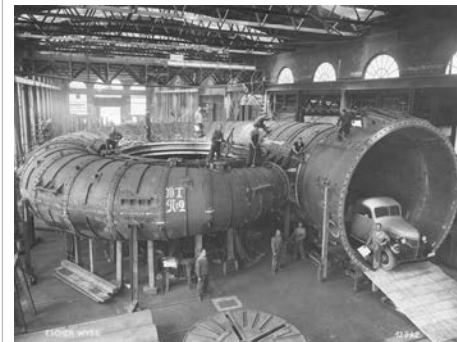
Titel: Sungari, Japan, Montage Spiralgehäuse
