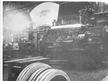
Titel: Kopierdrehbank mit Kaplan- schaufel für Schwörstadt Jahr: 1929 Signatur: VII.419.:34.1.1.2.1.21.01.
