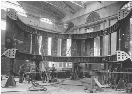
Titel: Assuan, Aegypten, Montage Stützschaufelring
