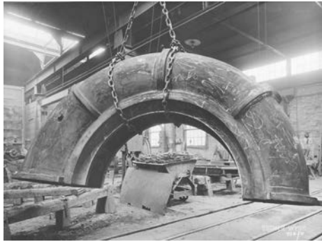
Titel: Reinigung der Gehäusehälfte eines Turbogebläses für die Anlage Jawata Jahr: 1935 Signatur: VII.419.:34.1.1.7.3.3.01.
