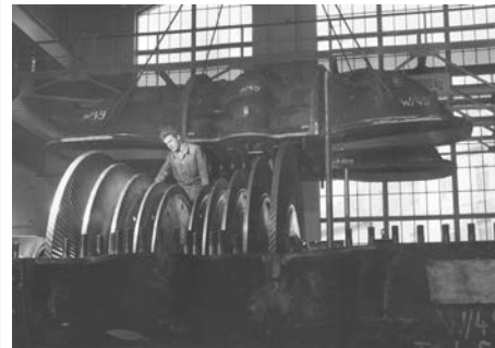
Titel: Niederdruckteil von Dampfturbine 55'000 kW W 49 Jahr: 1951 Signatur: VII.419.:34.1.1.6.2.20.01.
