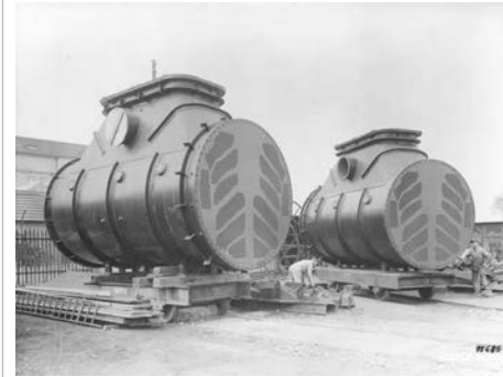
Titel: Choubrah, Dampfturbinen-Kondensator
