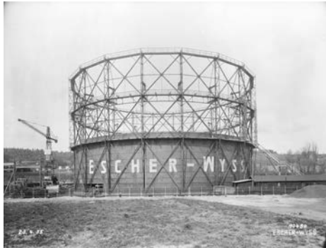
Titel: Kessel, Montage Schuss 9 im Schlieren
