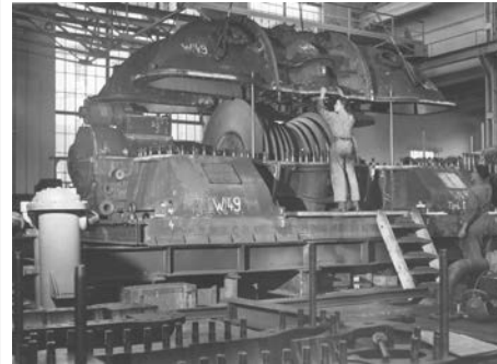
Titel: Niederdruckteil von Dampfturbine 55'000 kW W 49 Jahr: 1951 Signatur: VII.419.:34.1.1.6.2.19.01.
