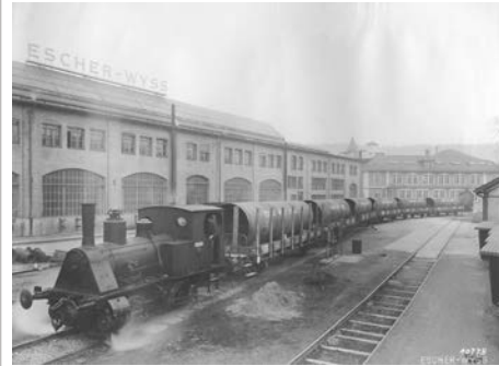
Titel: Transport von Rohrleitungen für Etzelwerk, verladen auf 6 Bahnwagen Jahr: 1938 Signatur: VII.419.:34.1.1.7.3.10.03.
