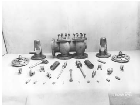
Titel: Details zum Absperrventil von Dampfturbine Nikonpulp Jahr: 1938 Signatur: VII.419.:34.1.1.6.1.36.01.
