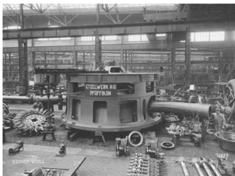
Titel: Wasserturbine mit Laufrad Etzelwerk
