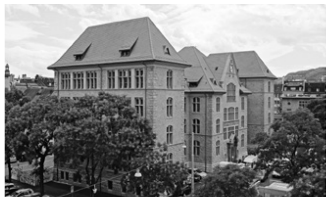
Das instandgesetzte Schulhaus Kern. (Bild: Marc Huber)
