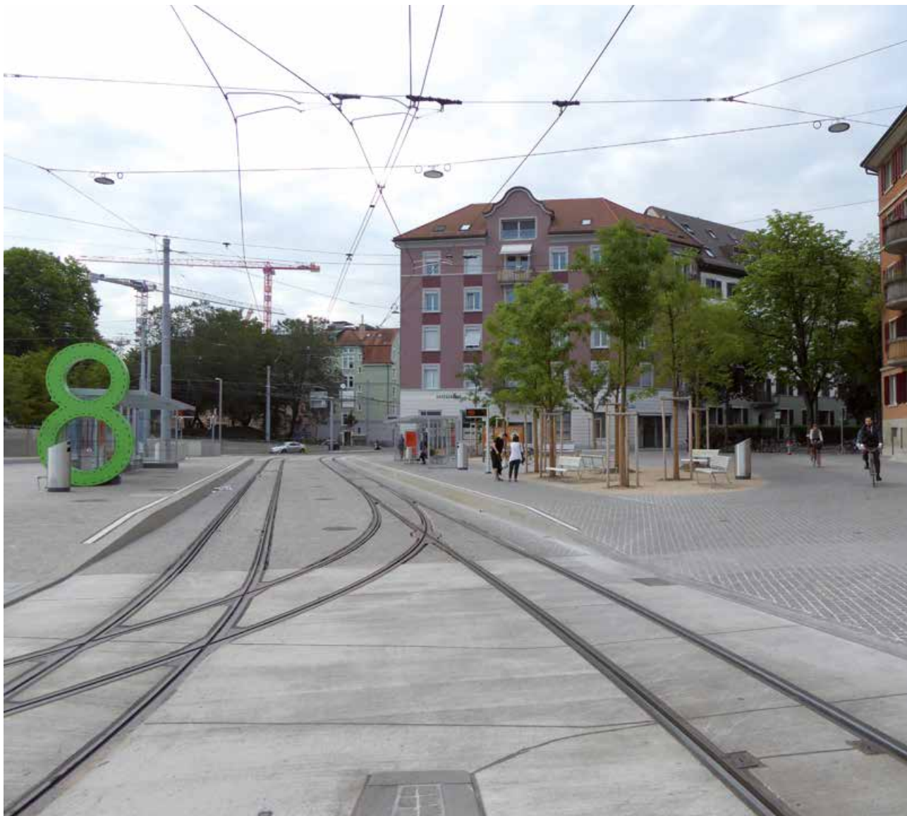
Neu gestalteter Hardplatz. Foto: Stadt Zürich, Tiefbauamt
