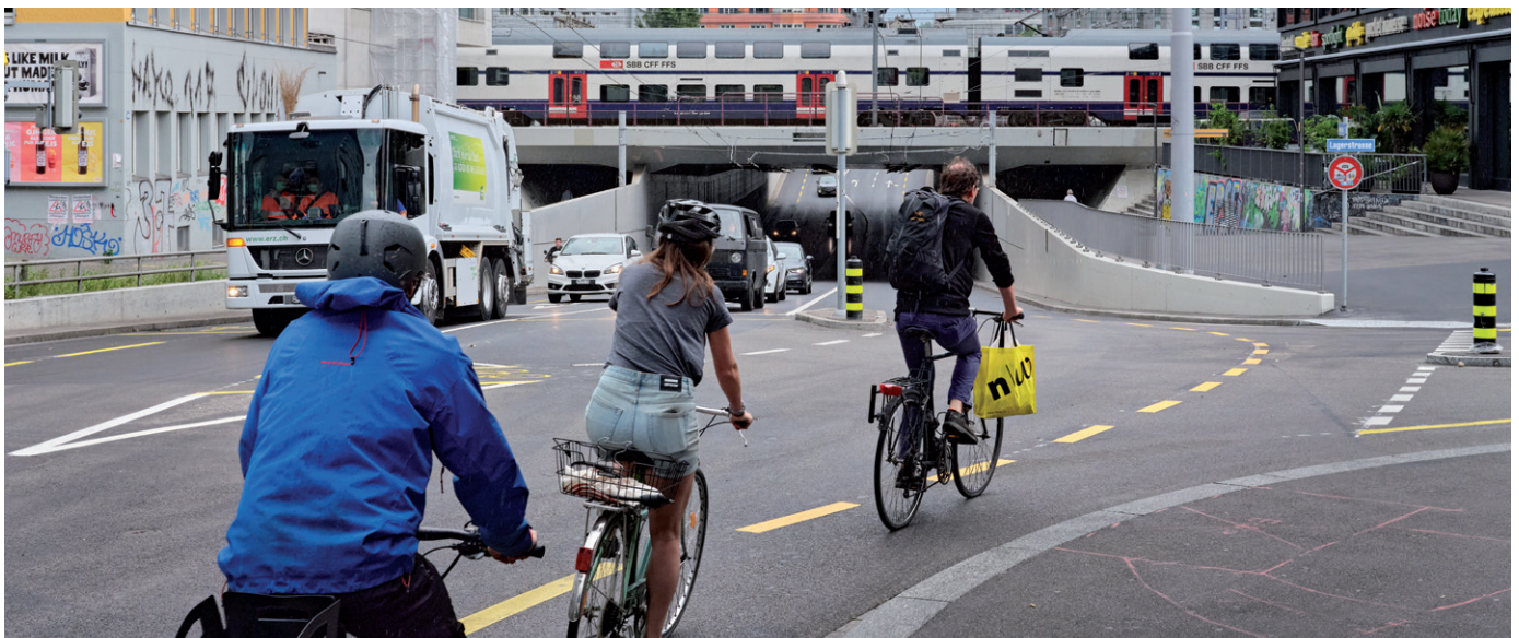
Velostreifen Langstrasse. Foto: Stadt Zürich, Tiefbauamt
