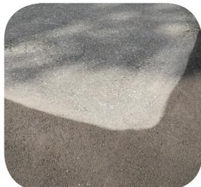
Abb 23: Aufgehellter, oberflächenbehandelter Asphaltbelag
