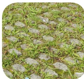
Abb 12: Pflasterung mit breiten und begrünten Fugen
