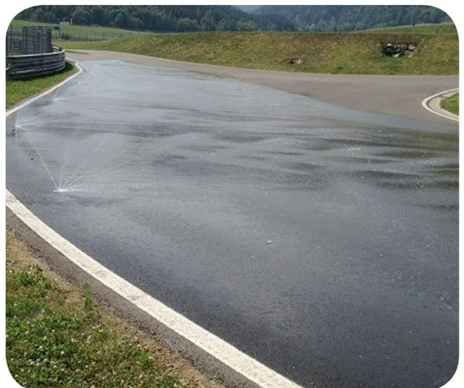
Abb 31: Sprinklerdüsen in einem Fahrtrainingscenter
